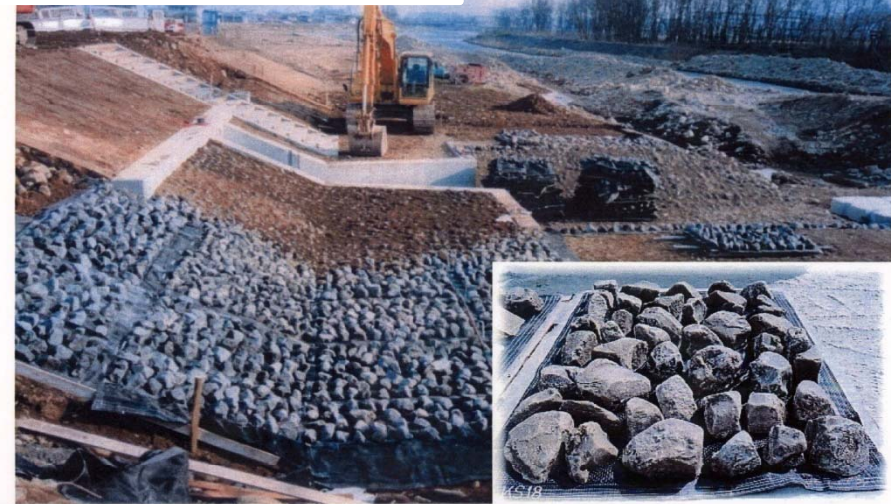
山形市須川護岸工事 ゴミ溶融スラグ石護岸材で共生環境を整備
