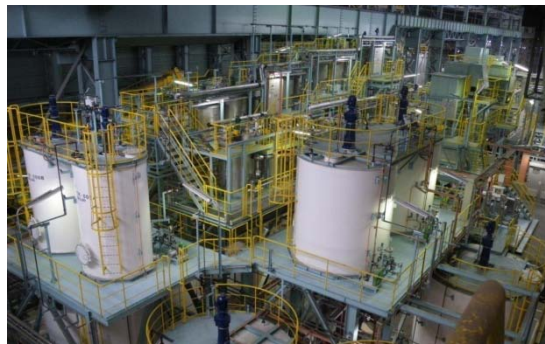
鉱石スラリータンクとNi浸出反応装置
