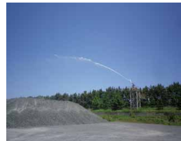
スラグヤードにおける散水
