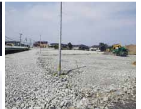
パムコスラグ路盤材を使用した道路
