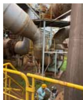
排ガス測定の様子
