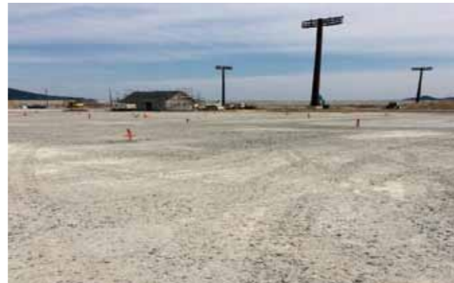
震災復興地の土木用資材としての活用
