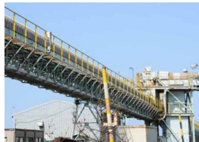
鉱石運搬コンベア ：荷下ろしが終わった鉱石等を、全長2.4kmに及ぶコンベアで工場まで運びます。
