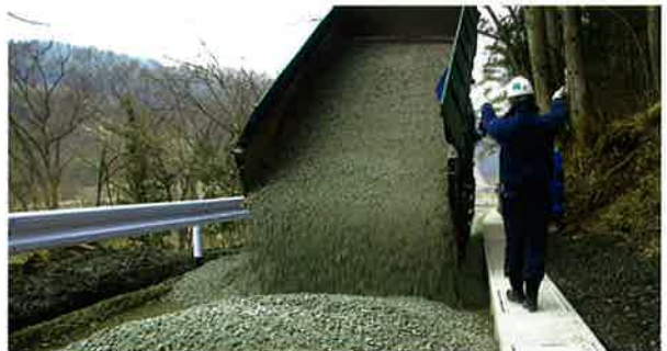
道路路盤材 (スラグ施工の道路工事)
