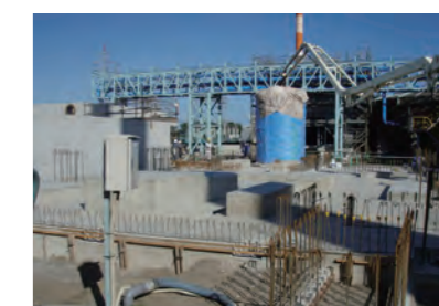
建設中の排水終末処理施設
