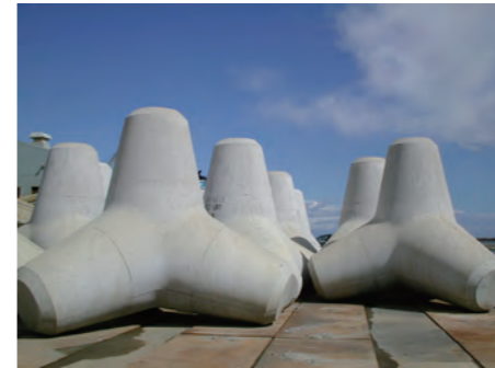
重量コンクリート消波ブロック
