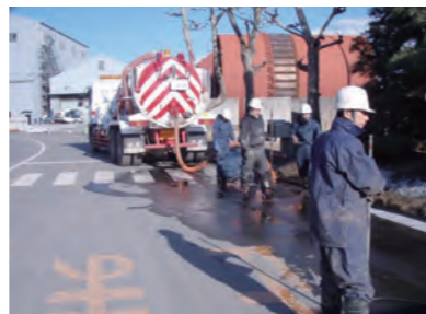
震災汚泥吸引作業
