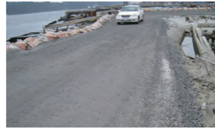
気仙沼市に提供した路盤材の使用状況
