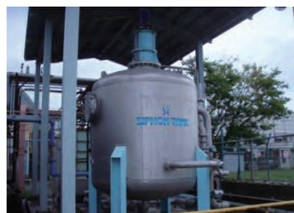
ろ過材洗浄機能付水処理用ろ過装置
