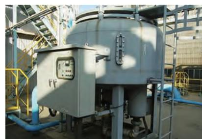
循環水専用フィルター式濾過器
