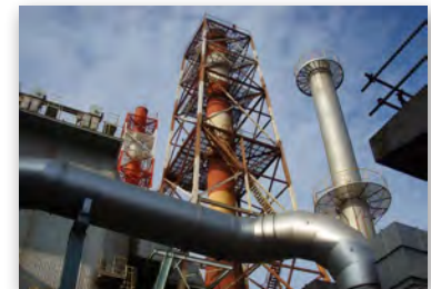
管理対象となっている煙突
