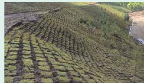
斜面安定と緑化のために植えられた芝生(手前)と樹木(奥)
