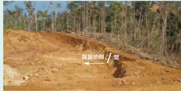
採掘地の外縁に高さ2-3mの壁を作ることで、採掘時の土砂が採掘地外に流出しないよう工夫
