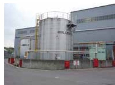
屋外タンクヤード
