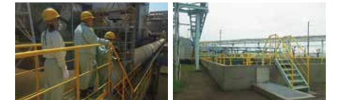
集塵機東側の連絡通路
