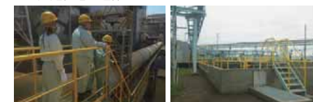
集塵機東側の連絡通路
