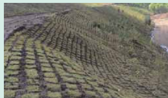
斜面安定と緑化のために植えられた芝生(手前)と樹木(奥)
