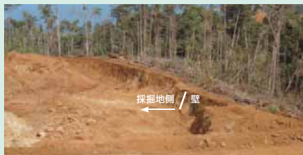
探掘地の外縁に高さ2-3mの壁を作ることにより、探掘時の土砂が探掘地外に流出しないよう工夫
