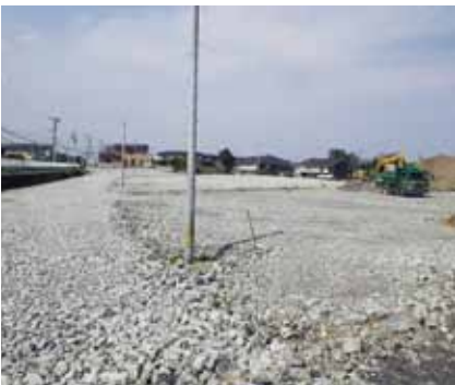
パムコスラグ路盤材を使用した道路
