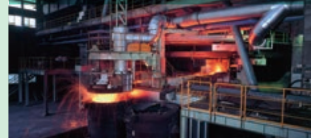
フェロニッケル製錬電気炉
