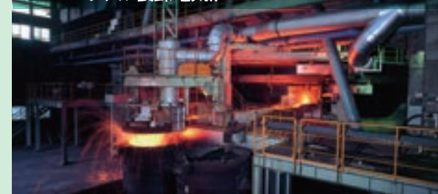
フェロニッケル製錬電気炉
