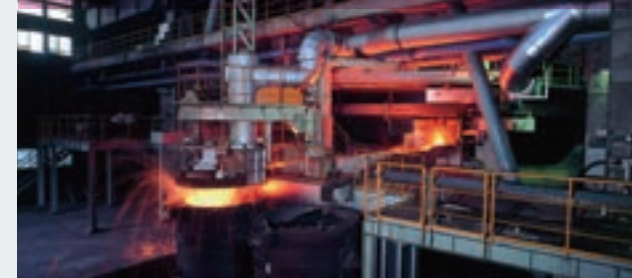
フェロニッケル製錬電気炉
