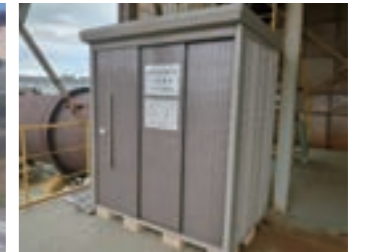
津波二次避難場所 備品保管用物置の設置
