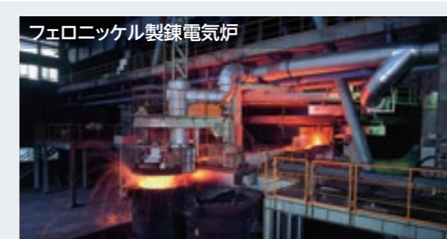
世界最大級の電気炉であり、鉱石等を電気抵抗熱で溶かし、フェロニッケルを製錬します。
